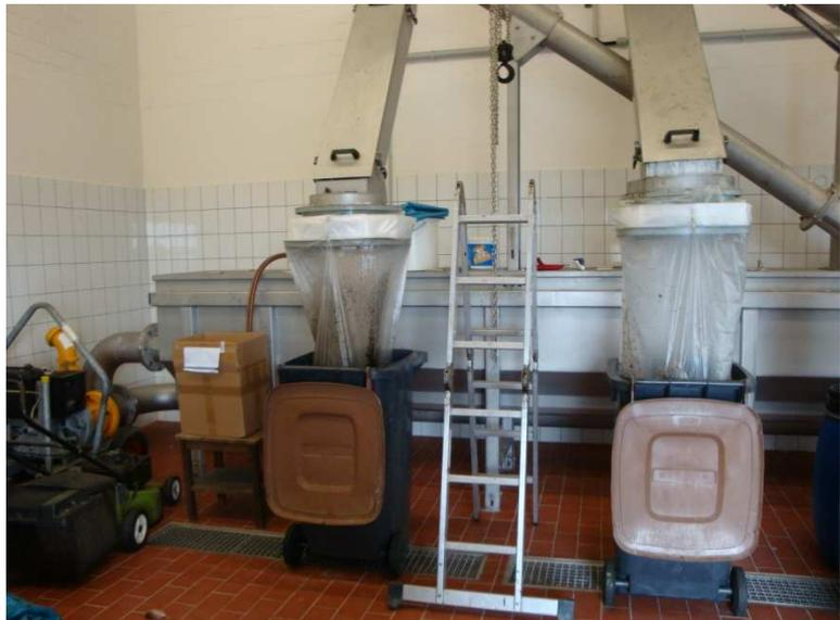
Abbildung 2-35: Entsorgung des Rechenguts in der Kläranlage
