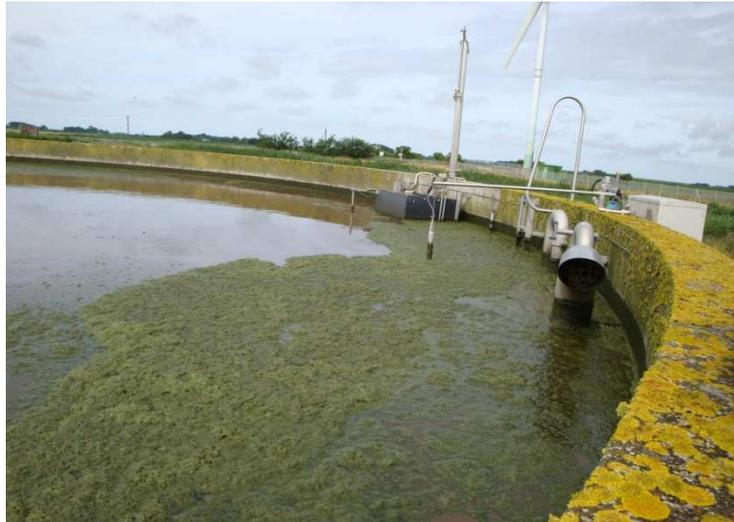
Abbildung 2-36: Belebungs- und Nachklärbecken, das sogenannte SBR-Becken.
